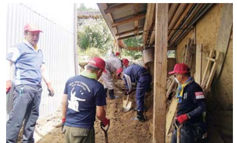
主に泥出しの作業をしました
